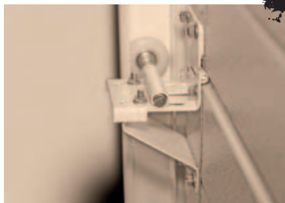
Cerniere laterali ad angolo e sporgenze poco estetiche e pericolose
