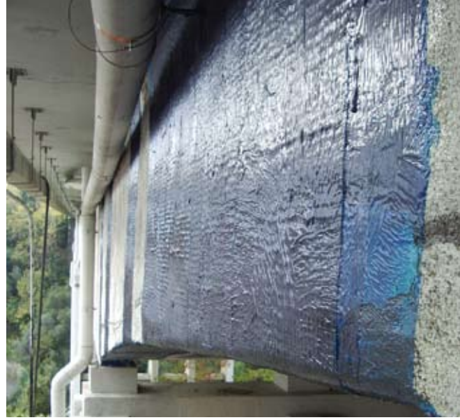
6.2.1 Fasciature MBrace Alto Modulo ad U per il rinforzo al taglio
