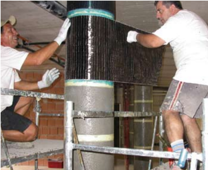
6.3.1 Confinamento pilastro in cemento armato
