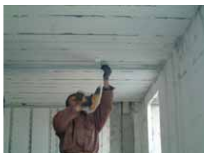
Posizionamento e avvitatura del profilo angolare a soffitto
