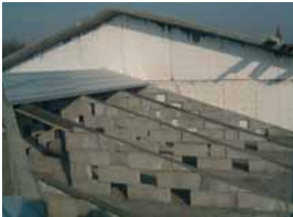
adattamento e posa pannelli sui muretti
