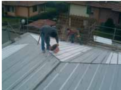
sistemazione prima di ricevere la rete di ripartizione
