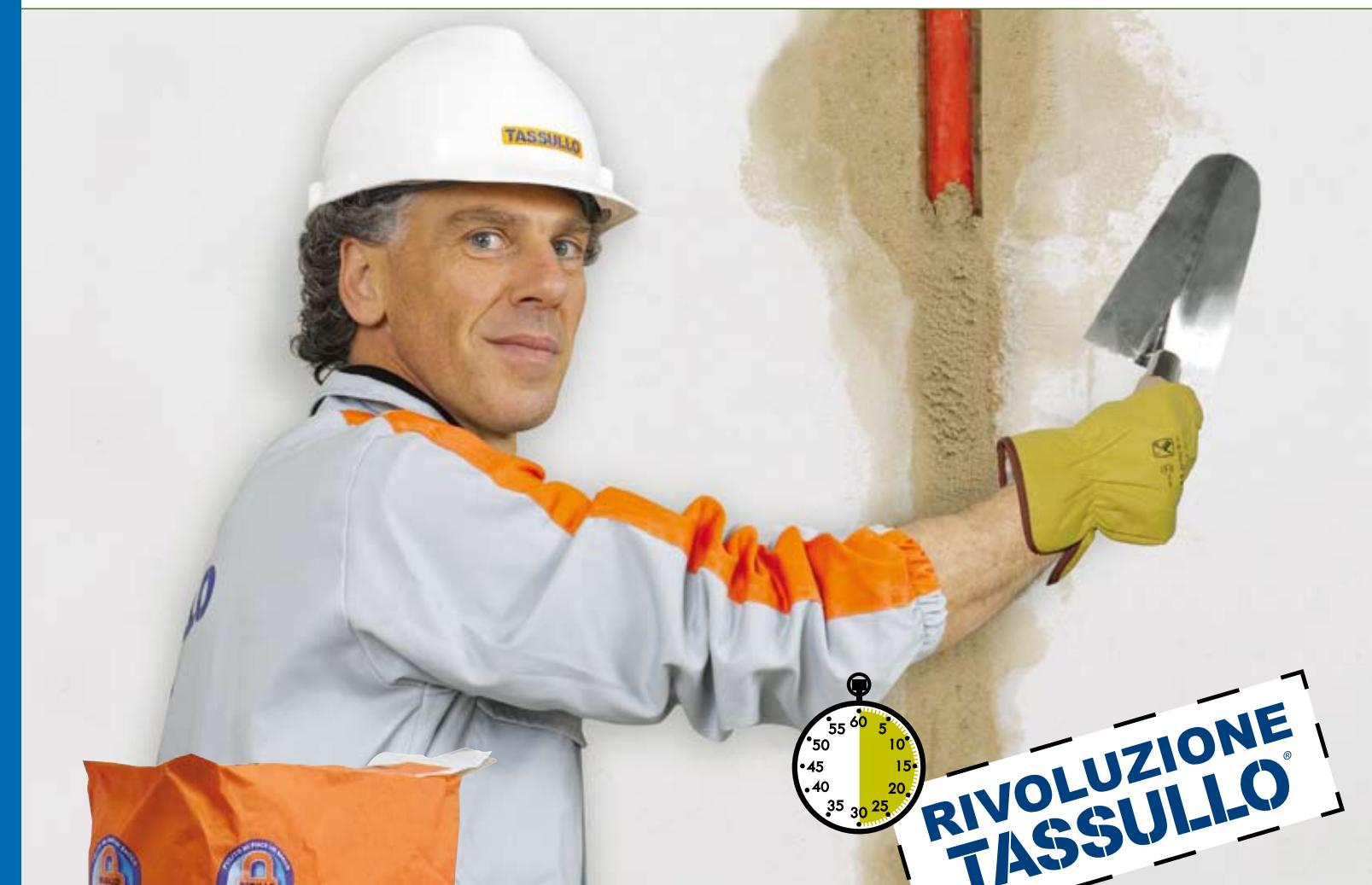
T-Flash è l'unica malta rapida immediatamente rifinibile appositamente studiata per chiudere in modo sicuro e veloce tracce elettriche, idrauliche e fori.
