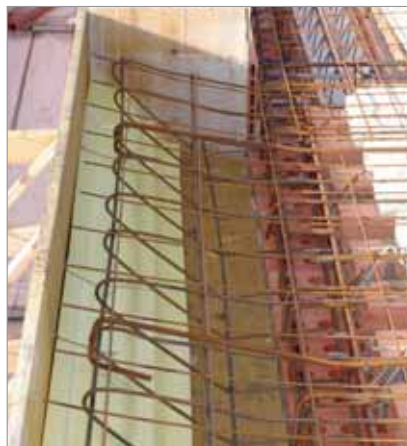
Posa del ferro d'armatura
