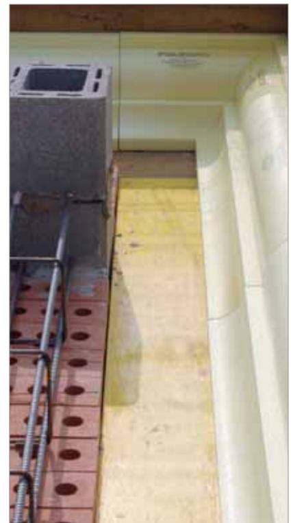
Posa dei casseri sul banchinaggio
