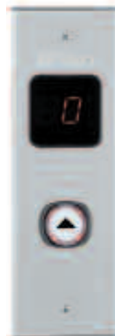
Pulsante di chiamata e segnale occupato; display indicazione piano
