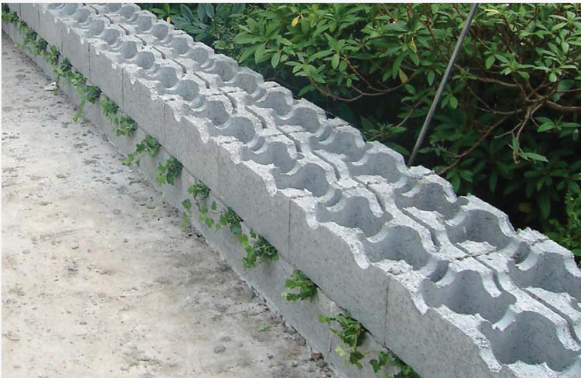
6 - Completamento del secondo corso
