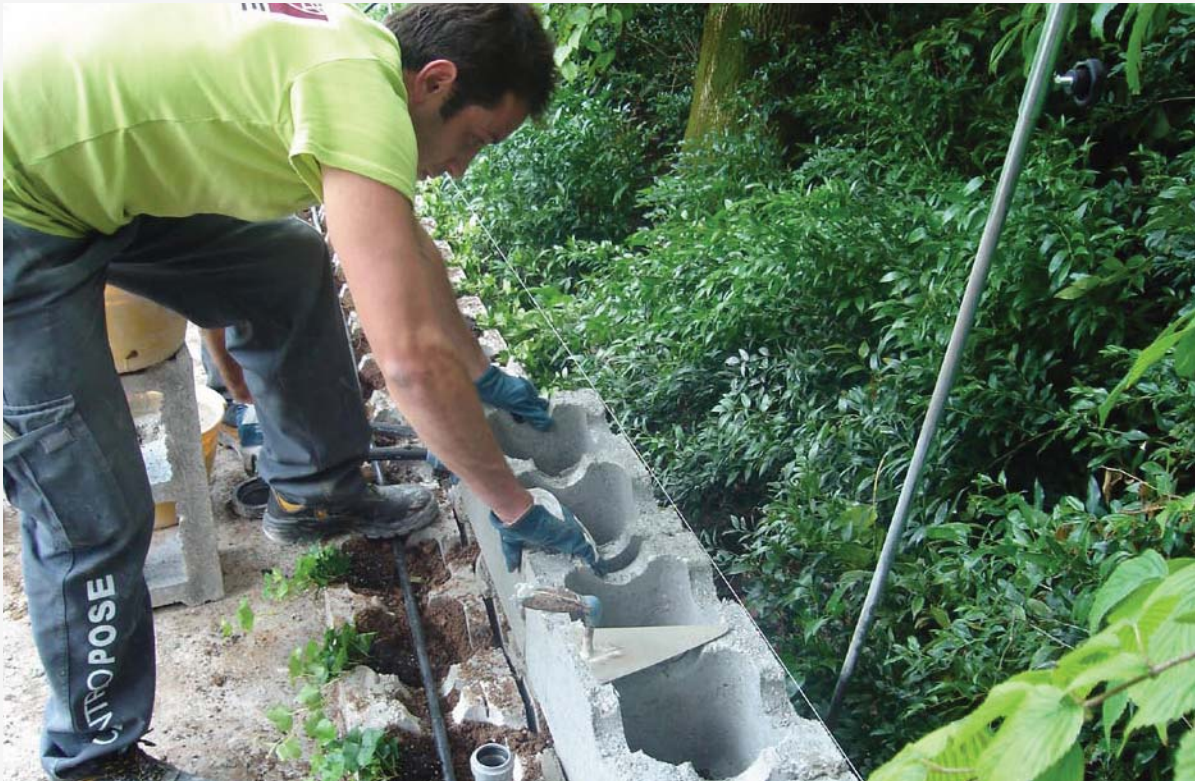
5 - Posa del secondo corso di blocchi
