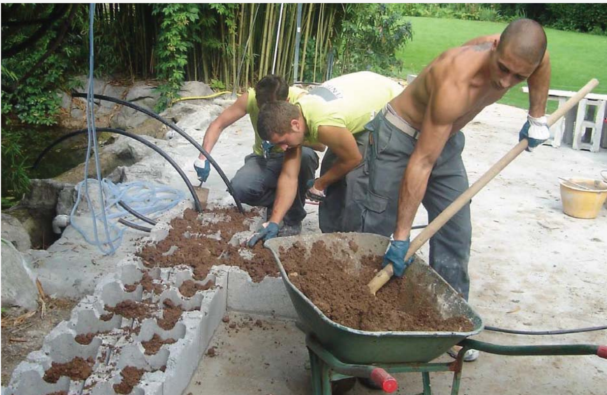
2 - Riempimento del primo corso di blocchi con terreno vegetale
