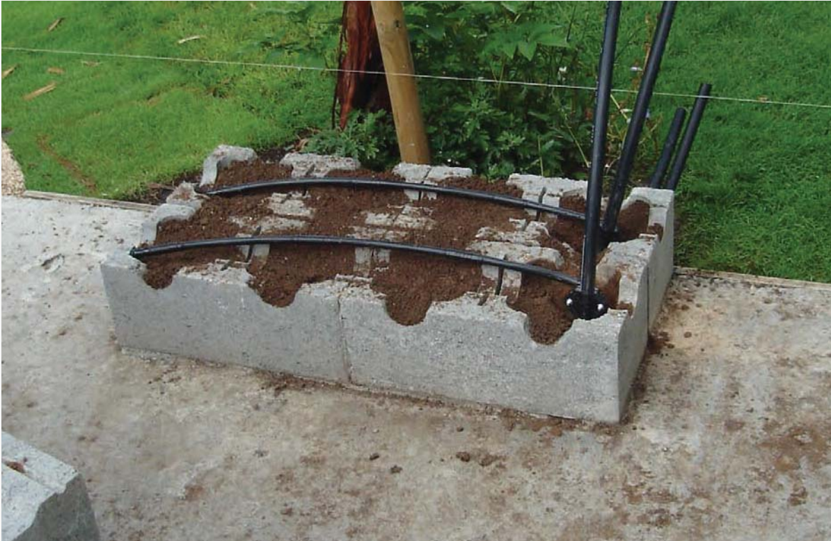
1 - Posa dei primi elementi e allacciamento idrico principale
