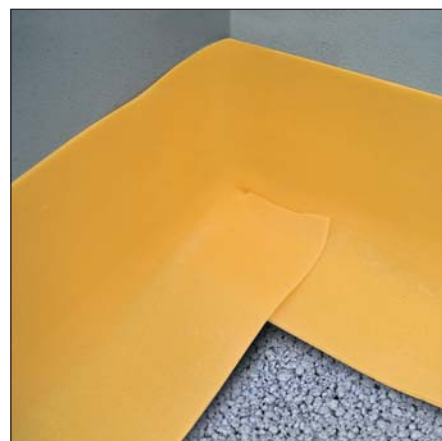
Posa della banda in corrispondenza di un angolo.
