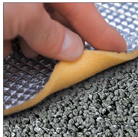
Sottofondo bistrato: posa del materassino.
