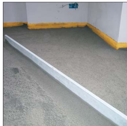
Realizzazione del massetto di finitura.
