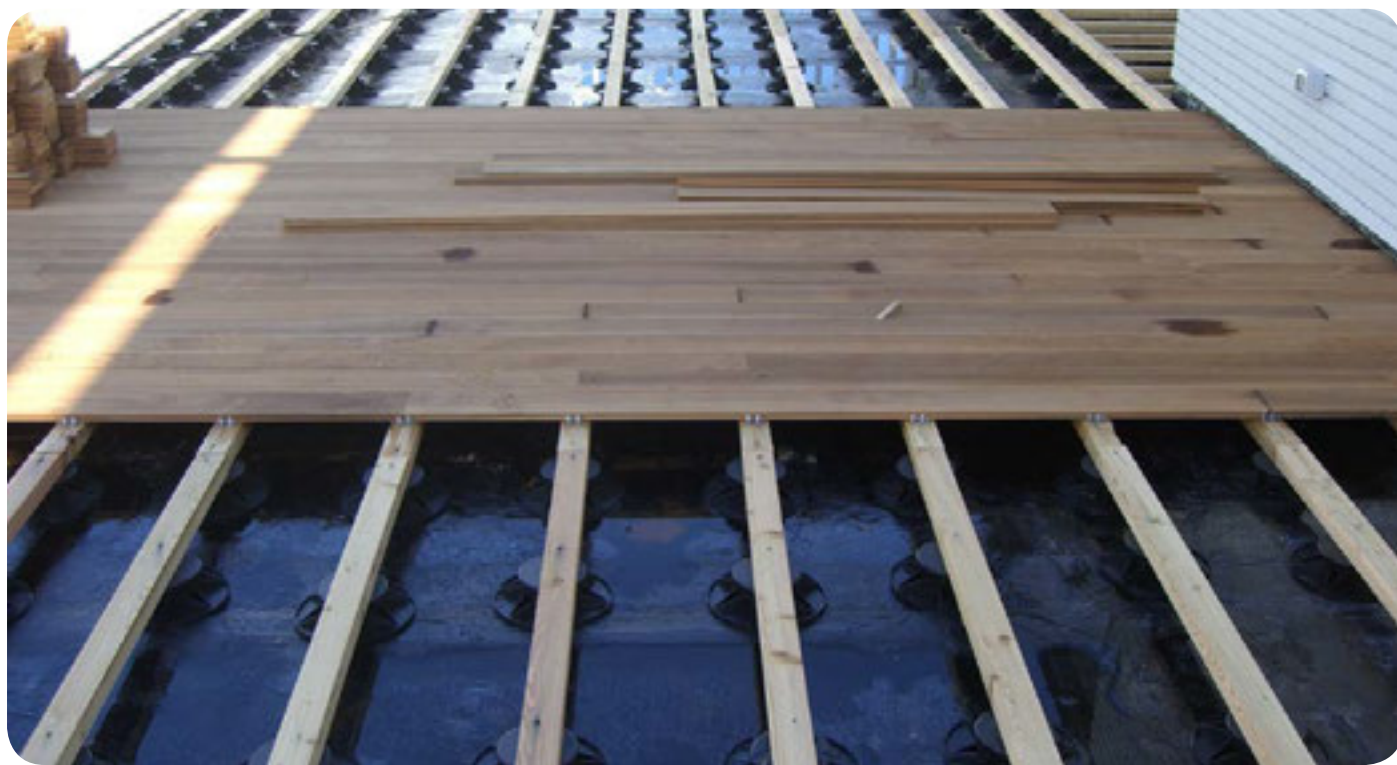
SUPPORTO A MARTINETTO Regolazione millimetrica continua
