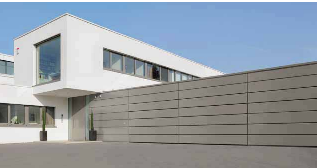
Rivestimento esterno a cura del cliente con pannelli in materiale composito in alluminio
