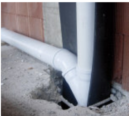
Isolamento attraverso un materiale disaccoppiante per evitare "ponti acustici"
