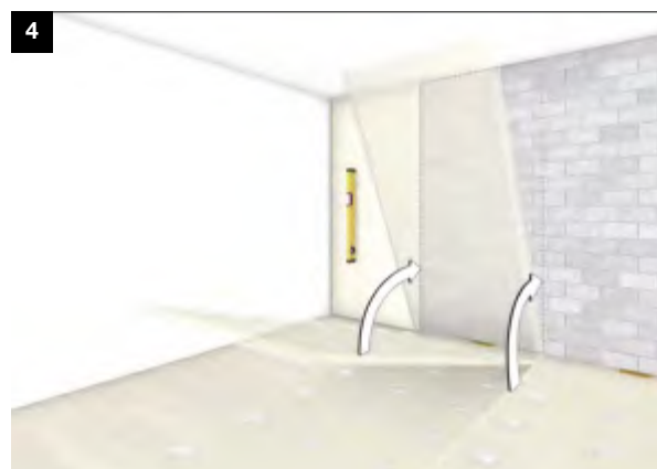
4. POSIZIONAMENTO LASTRE SULLA PARETE
