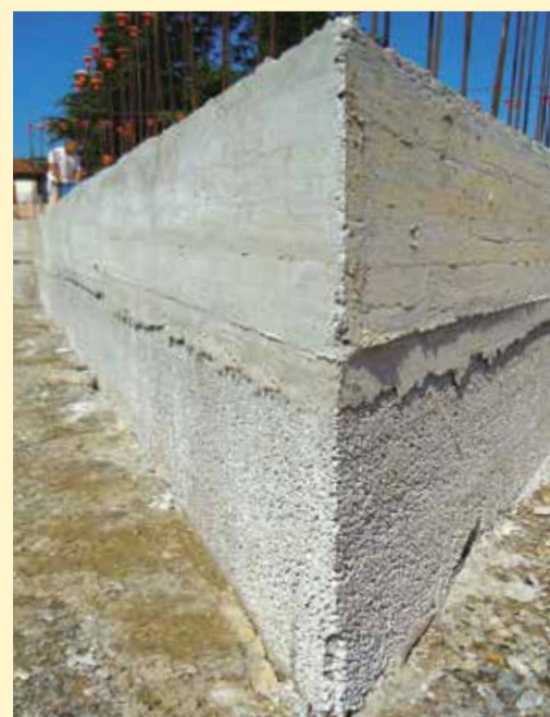
Vespaiso isolato in Leca TermoPiù cementato ad alta resistenza sotto platea di fondazione.
