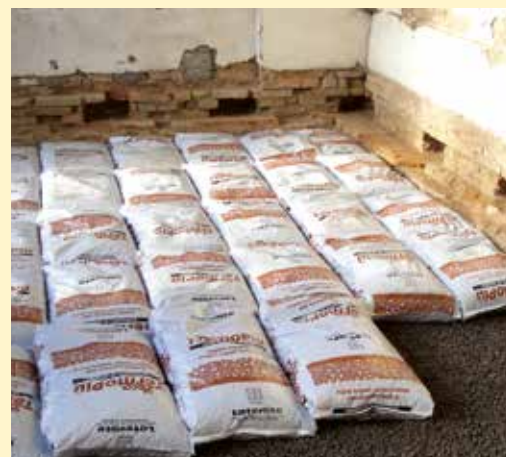
Sottofondo isolato contro terra in Leca TermoPiù in sacco.
