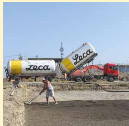
Vespaio isolato in Leca TermoPiù sfuso.
