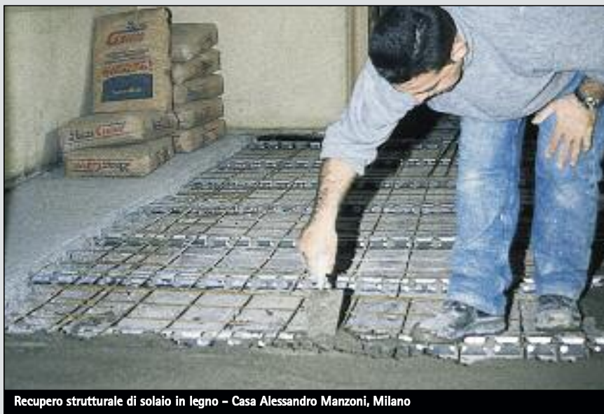
Consolidamento: connessione a pioli
