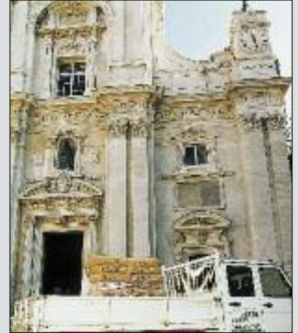
Restauro copertura Santuario di Loreto
