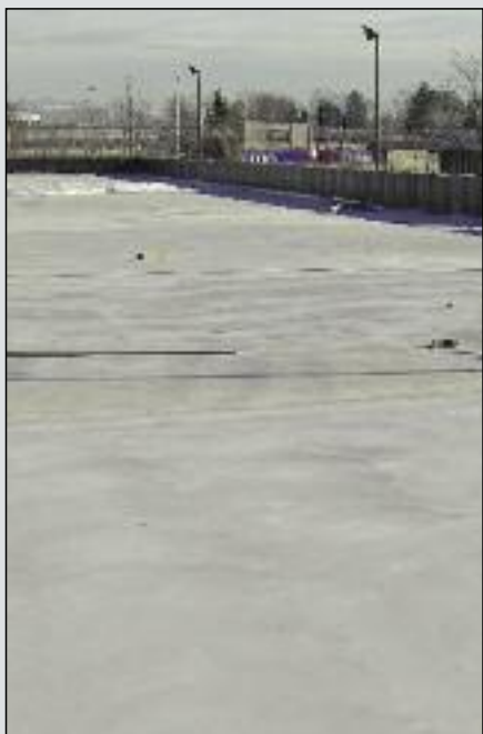
Pavimento industriale in copertura carrabile.
