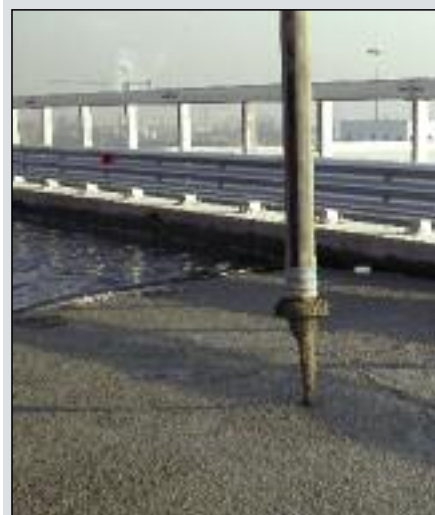
Pompaggio calcestruzzo da centrale di betonaggio.
