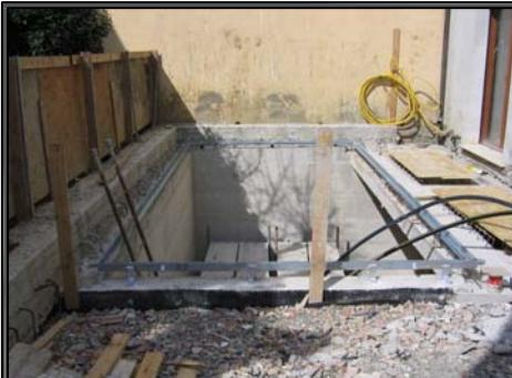
LA CANALINA VIENE FISSATA IN QUOTA STABILITA E ANCORATA AL SOLAIO TRAMITE DELLE ZANCHE DA CEMENTARE
