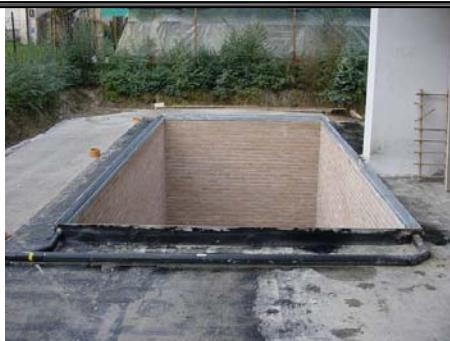
LA CANALINA VA POSATA PRIMA DI FARE IL SOTTOFONDO E RELATIVO MANTO DI IMPERMEABILIZZAZIONE
