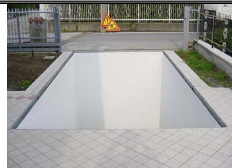
LA CANALINA VIENE POSIZIONATA A FILO DELLA FOSSA. IL PAVIMENTO FINITO DEVE COINCIDERE CON IL BORDO SUPERIORE DELLA CANALINA
