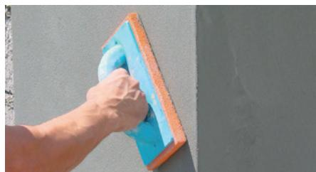
Il ciclo si conclude, per dare le maggiori garanzie di durabilità all'intervento, con un apposito protettivo anticarbonatazione (la carbonatazione è, come visto in precedenza, una delle maggiori cause di degrado del calcestruzzo): "C 285 BETON" finitura anticarbonatazione specifica per la protezione del calcestruzzo a base di copolimeri acrilici, cariche selezionate biossido di titanio e pigmenti idonei.
