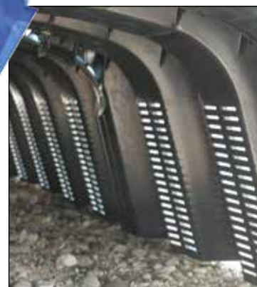
④ Fondo completamente aperto e superficie fessurata laterale, per una superficie percolante di 12.400 cm 2 ad elemento
