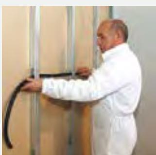
Facilità di alloggiamento della lana minerale all'interno dei montanti e della struttura;
