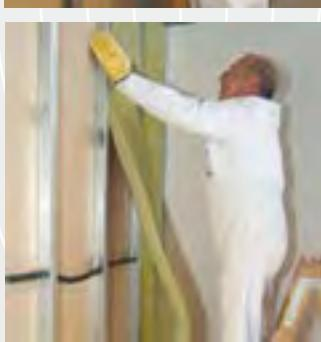
Larghezza e spessori adattati alle diverse **misure modulari** delle strutture metalliche dei sistemi a secco;
