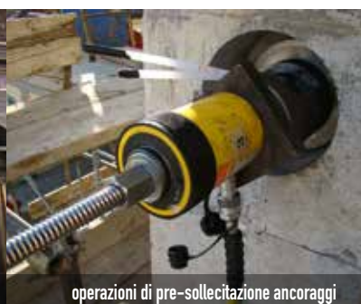
incatenamenti longitudinali esistenti
