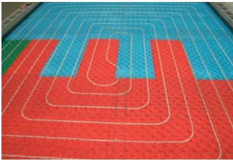
Con CT25 FIBERPLUS è possibile realizzare pavimentazioni riscaldanti/raffrescanti mediante l'inserimento al suo interno di "serpentine" radianti.
