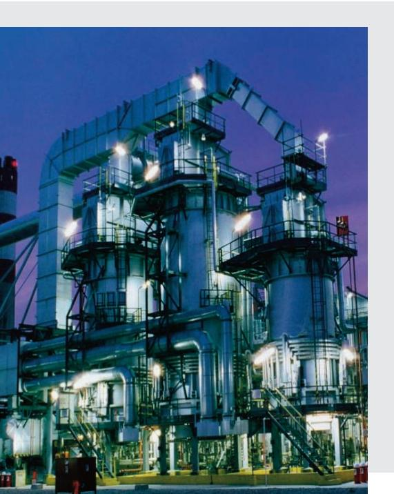
Gli incendi da idrocarburi insorgono in stabilimenti petrolchimici o in analoghe tipologie di installazioni a causa dell'ignizione di prodotti chimici o di carburanti. Dopo pochi minuti dallo scoppio dell'incendio la temperatura raggiunge i 1100°C e le strutture in acciaio non protette possono collassare a seguito della perdita di resistenza meccanica dovuta all'aumento della temperatura.
