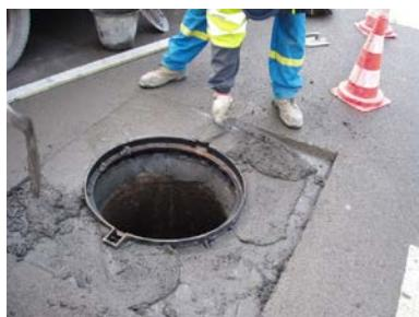
Gli spessori di applicazione sono compresi tra 10 e 150 mm (per interventi localizzati applicabile in spessori da 10 a 100 mm, per allattamento o fissaggio chiusini applicabile in spessori da 25 a 150 mm, per getti di ripristino o ringrosso applicabile in spessori fino a 50 mm). Per interventi di spessore superiore a quanto sopra indicato è necessario aggiungere aggregato lavato, privo di impurità nella tipologia e nella quantità da definirsi in funzione dello spessore richiesto.
