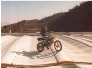
Nel 1983 nasce la **supercopertura Aliant**: un tegolo in c.a.p. fino a 18 metri dall'inconfondibile profilo ad ali di gabbiano. Aliant cambia per sempre il settore della prefabbricazione dando vita a un nuovo segmento di mercato (tegoli aliari) e si contraddistingue fin dalle origini per le sue caratteristiche uniche e rivoluzionarie (monoblocco 100% prefinito in stabilimento).
