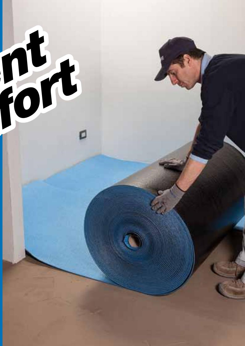
Al fine di evitare la formazione di ponti acustici, l'isolamento mediante l'impiego di **Mapesilent Comfort** deve essere completato utilizzando gli altri prodotti della linea: **Mapesilent Band R** e **Mapesilent Tape**, come di seguito illustrato.
