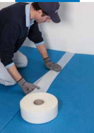
Una volta verificata la perfetta sovrapposizione dei teli di Mapesilent Comfort, chiudere e sigillare tutte le sovrapposizioni con il nastro Mapesilent Tape
