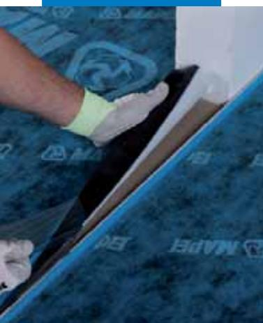
**Srotolare il telo di Mapesilent Roll posizionandolo alla base della parete e distenderlo con lo strato fibroso (parte chiara) rivolto verso il basso, seguendo il lato più lungo della stanza. Stendere il secondo telo posizionandolo alla base della parete, avendo cura di rimuovere la pellicola sul rovescio dell'aletta laterale, da sovrapporre al telo adiacente (circa 5 cm) al fine di garantire la continuità dello strato fibroso**
