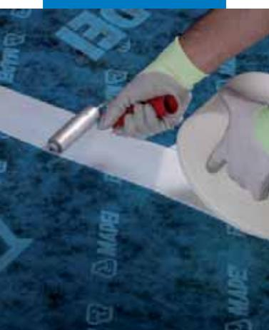
**Una volta verificata la perfetta sovrapposizione di Mapesilent Roll, chiudere e sigillare tutte le sovrapposizioni con il nastro Mapesilent Tape**
