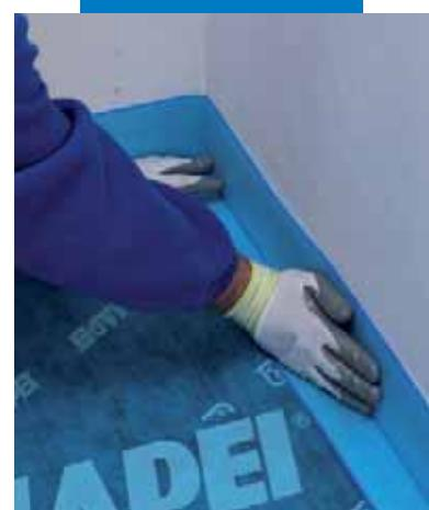
Accostare i vari rotoli di Mapesilent Band R. Asportare il film di protezione sul rovescio ed incollare per tutto il perimetro del locale
