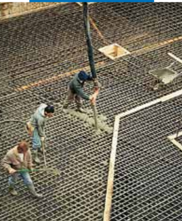
Particolare del getto di platea con Cls superfluido grazie a Mapefluid PZ500
