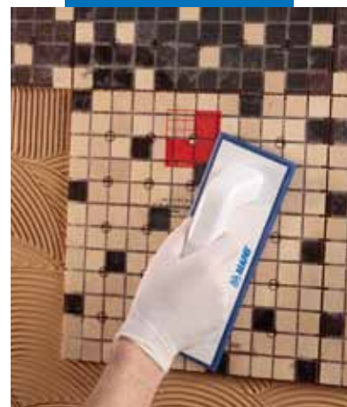
Pressatura e registrazione del foglio di mosaico
