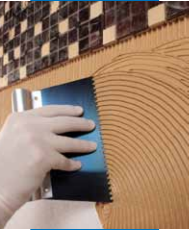
Distribuzione dell'adesivo con spatola Mapei n. 4
