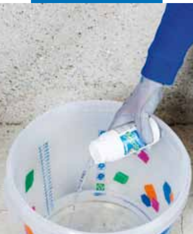
Aggiunta di Mapetard ES all'acqua d'impasto di Planitop Rasa & Ripara R4 o Planitop Rasa & Ripara prima della miscelazione
