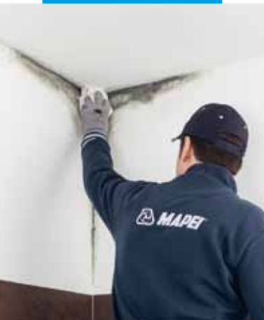
Pulizia delle superfici con Silancolor Cleaner Plus
