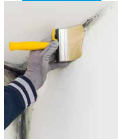
Applicazione del primer (preferibilmente Silancolor Primer Plus )
