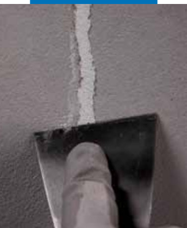
Lisciatura superficiale con spatola
