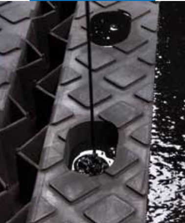
Colatura di Mapeflex PU65 puro nelle sedi degli ancoraggi
