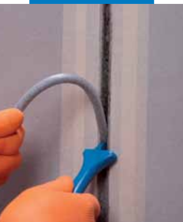
Inserimento all'interno della sede del giunto di Mapefoam
