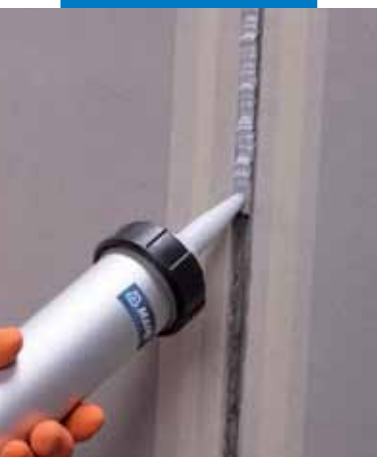
Applicazione di Mapeflex PU40
