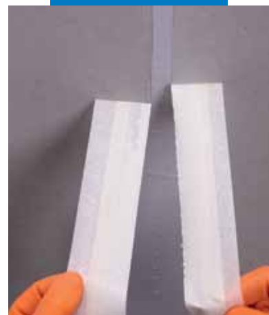
Asportazione della mascheratura effettuata in precedenza con carta adesiva, al fine di evitare le sbordature
