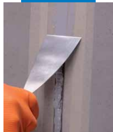
Lisciatura di Mapeflex PU40
