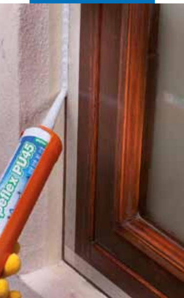
Sigillatura elastica di giunti di costruzione
