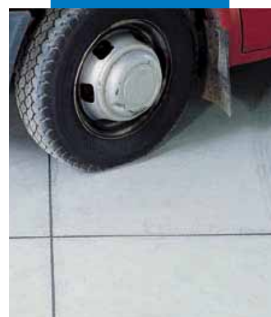
Giunto di frazionamento di pavimento industriale in cemento con Mapeflex PU21
