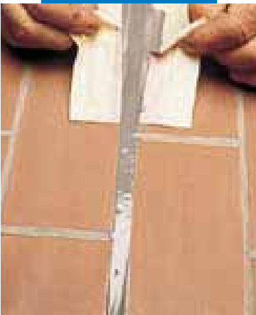
Giunto di dilatazione di gres rosso con Mapeflex PU21
