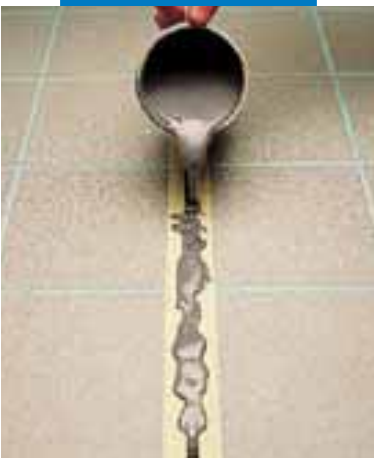
Riempimento del giunto con Mapeflex PU21
