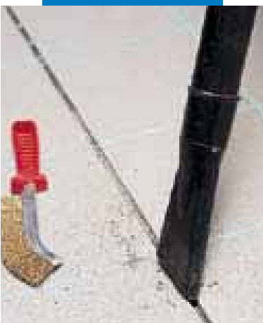
Pulizia del giunto con aspirazione della polvere
