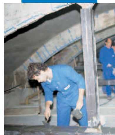
Getto con Mapegrout Colabile in cassero metallico
