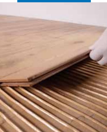
Posa del parquet
