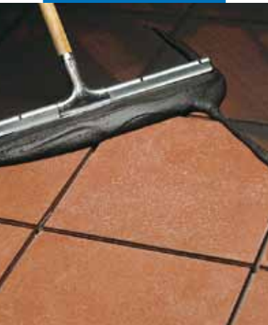
Stuccatura di pavimento in cotto con racla
