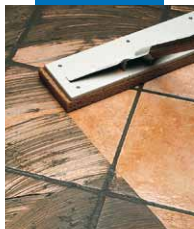
Pulizia di monocottura con spazzolone di spugna
