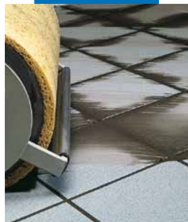
Finitura a pavimento con macchina
