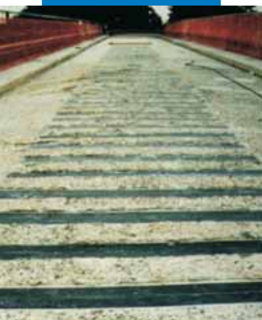
Soletta rinforzata con lamine di Carboplate
