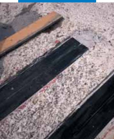
Lamine di Carboplate applicate in apposite sedi create sulla soletta
