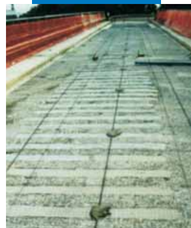
Lamine di Carboplate coperte con Mapegrout BM a chiusura delle sedi
