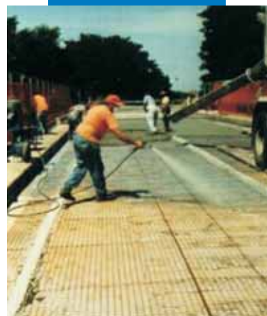
Applicazione di primer epossidico
