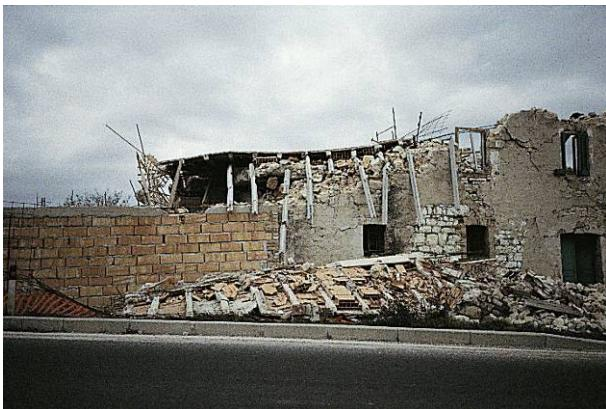
Crollo di un’abitazione in corso di ampliamento, in località Boschetto. In casi come questo, dove è ben visibile la struttura spingente della copertura, la causa dei danni è da attribuire all’imperizia di opere di ristrutturazione ai limiti dell’abusivismo.
