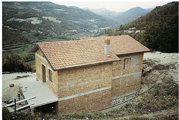
Gli edifici più recenti in muratura portante (anche non armata) ben progettati e costruiti in blocchi di laterizio hanno manifestato una notevole capacità di resistenza al terremoto. Nell’immagine, una costruzione in prossimità di Sellano, in località Cerreto, in corso di ultimazione.
