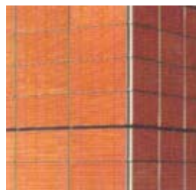
R. Piano Ampliamento IRCAM, Parigi 1988 Paramento esterno in elementi laterizi faccia a vista intelaiati ed appesi
