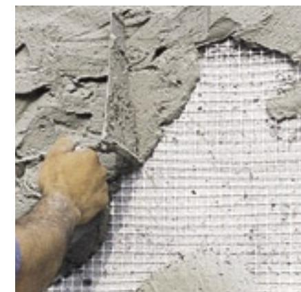
**Tenax ARMAFLEX** è l'armatura ideale per intonaci da 1 fino a 2-3 cm di spessore, poiché scarica lungo le sue maglie la fessurazione da ritiro, contrastando così il formarsi di fessure marcate.
