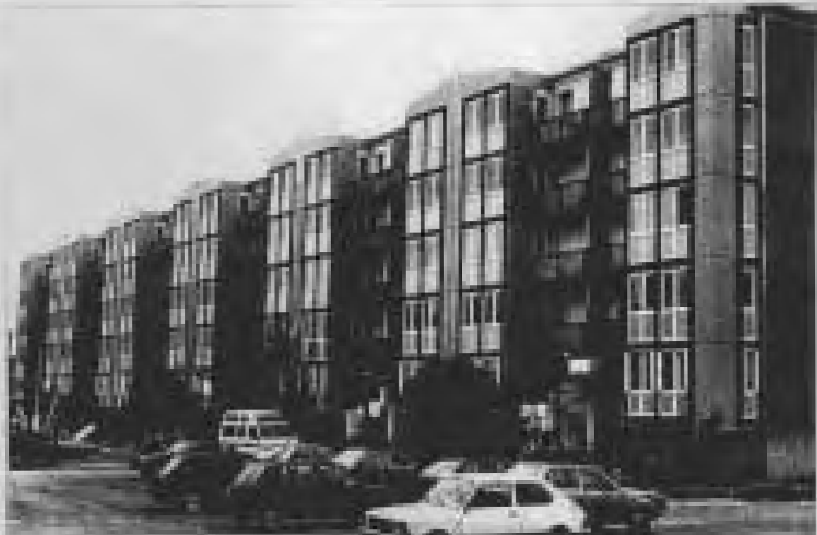
Fig. 43 - Piantina Chavichiani. Vista d'insieme della l'edificazione di appartamenti. L'intervento di ristrutturazione, oltre ad aver migliorato il comfort abitativo, ha aderito all'ordine del nuovo disegno urbanistico.
