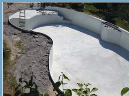
> La realizzazione del fondo in calcestruzzo, montaggio degli accessori e dell'impianto di filtrazione
