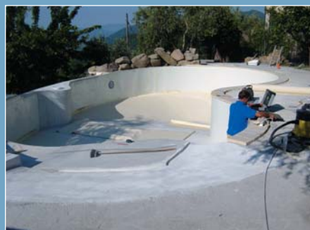
> La posa del rivestimento in PVC
