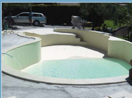
> Il riempimento con l'acqua
